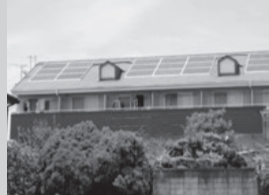
太陽光発電パネルを屋根に取り付けたジュネス書写
