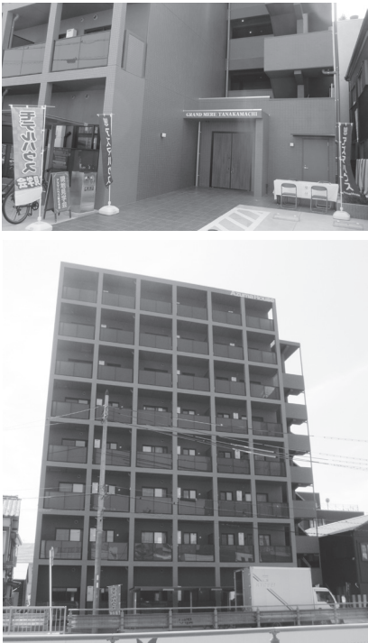
エントランス(上)と全景
