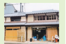
こうして工事は始まった
