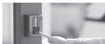
マンションインターホン リニューアル工事
