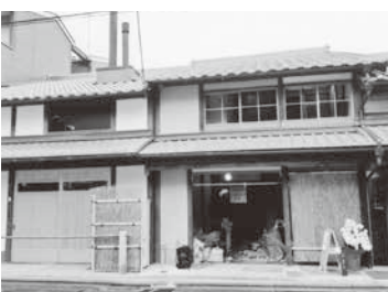
あちこちで京町家工事が
