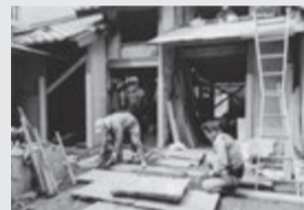
古い石、井戸、古木。工事現場
