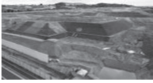
造成が進む駅西側
